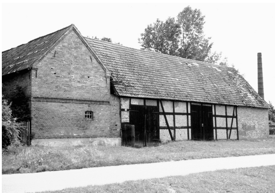
Ryc. 3. Sławsko. Przykład różnicy kolorystycznej wynikającej z wypełnienia przestrzeni pomiędzy elementami konstrukcji drewnianej cegłą lub pobieloną gliną.
