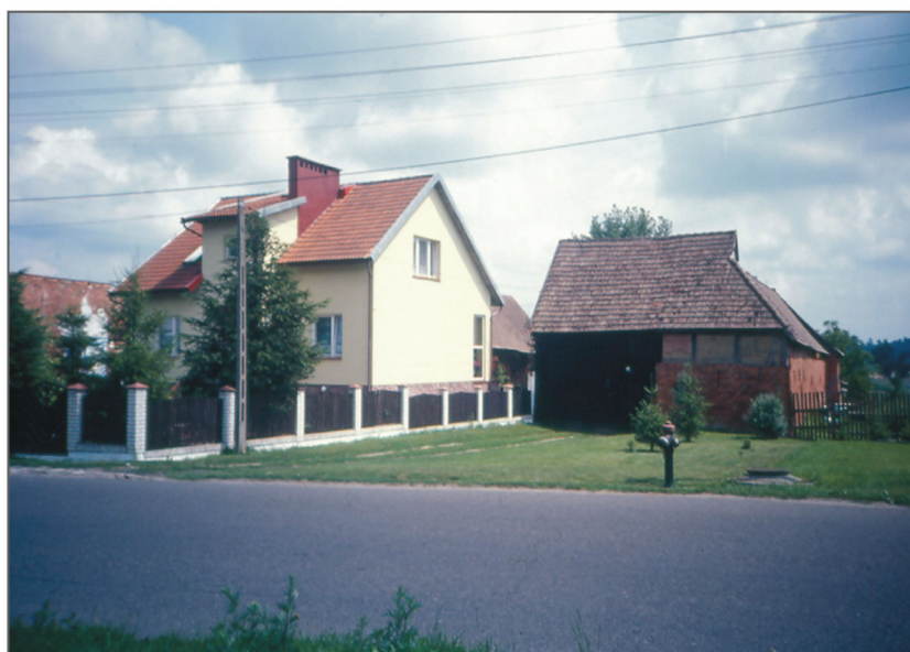
B. Sławsko. Współczesna deformacja budynku bramnego. Fot. E. Raszeja, 2003
